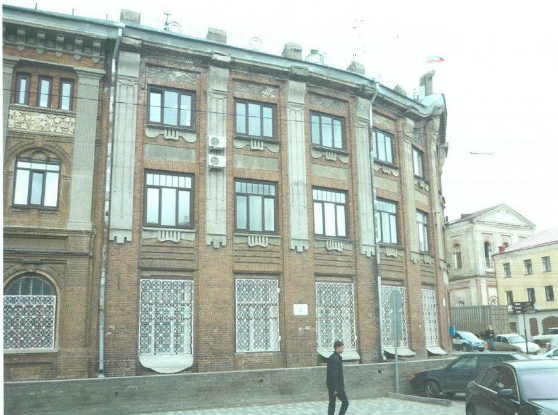
Фото 2. Вид на южный фасад объекта культурного наследия. Автор съёмки – Брызгалов Ю.П., дата съёмки – 15 сентября 2015 г. Кировская область, г. Киров, ул. Спасская, дом 15 литер А «Магазин П.П. Клобукова».
